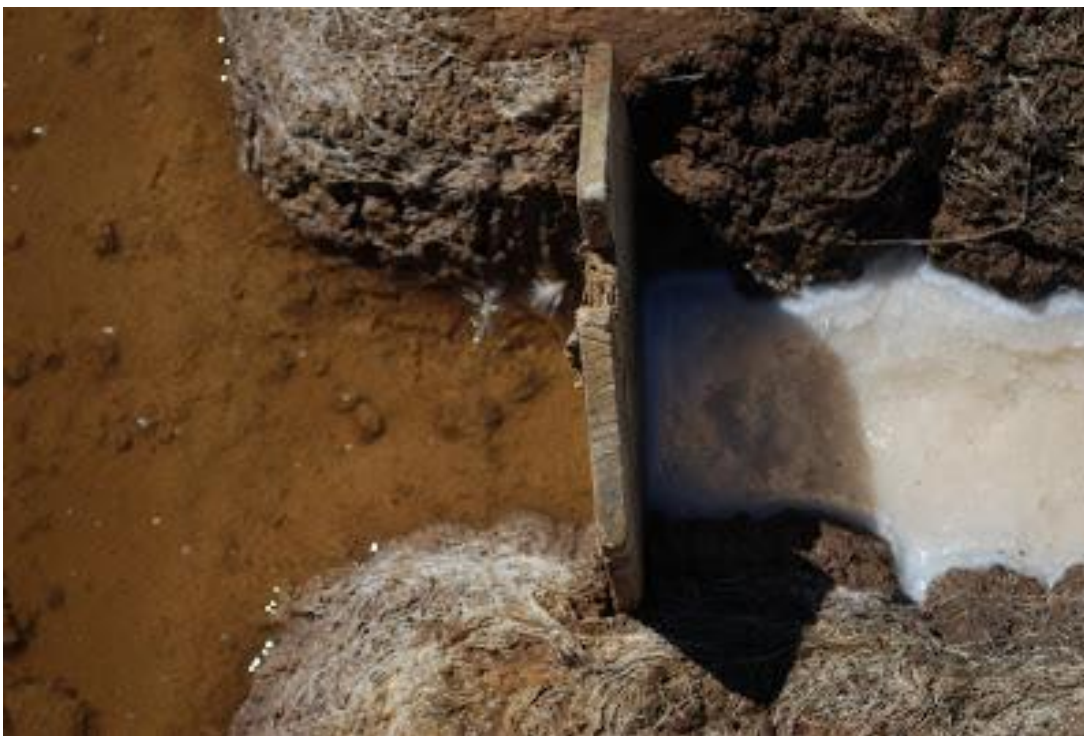
Imagen 2. Filtración de agua marina por topes en Lo Valdivia. Fuente: Proyecto SALINAS Lo Valdivia
